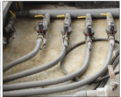
圖3 自動肥灌系統之管路採電磁閥分區，各田區輪流單獨灌溉
