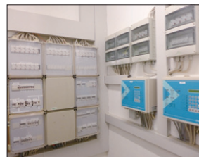
圖94 由Munters公司設置之不同種雞蛋禽舍的模組化當地控制模組
