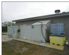
圖97 由Munters公司設置之節能型禽舍內循環通風過濾裝置-2
