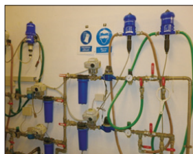
圖95 禽舍內清潔用水之過濾系統
