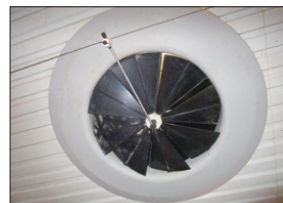
圖92 種雞蛋禽舍上方垂直設置的軸流通風扇，可由連桿機構進行扇葉角度調整，或是將通風孔關閉，使禽舍與外界大氣隔離
