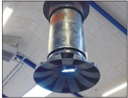
圖101 密閉禽舍垂直軸流式進氣通風
