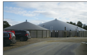
圖105 第一期已蓋設完成進行沼氣生產的料槽以及反應槽
