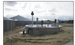
圖106 第二期正在蓋設試運轉的沼氣產氣槽及儲氣設備
