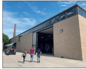
圖1 內布拉斯加大學曳引機測試實驗室主體建築
