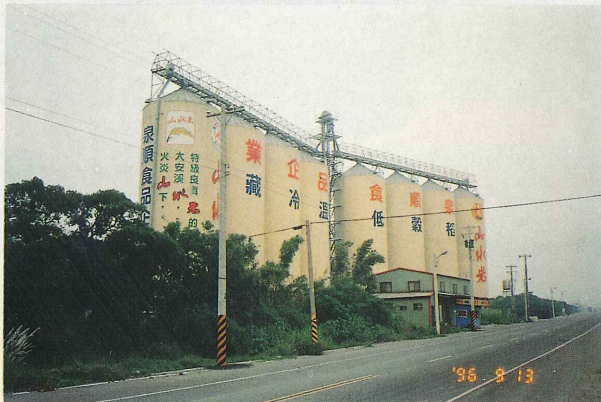
泉順苑裡廠山水米自動化冷藏穀倉工程
